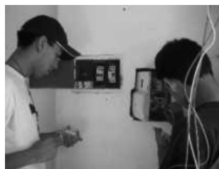
Figura 6. Capacitación de jóvenes (instalaciones eléctricas) - Proyecto "Molino Blanco".
