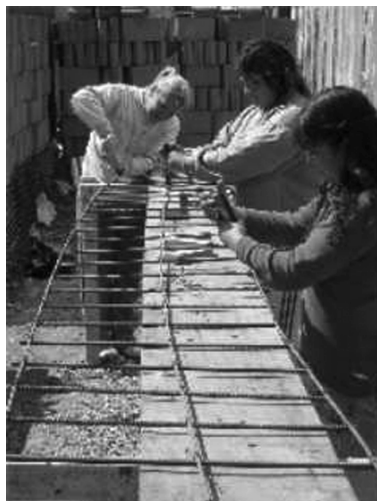
Figura 5. Capacitación en autoconstrucción - Proyecto "La Lagunita".
