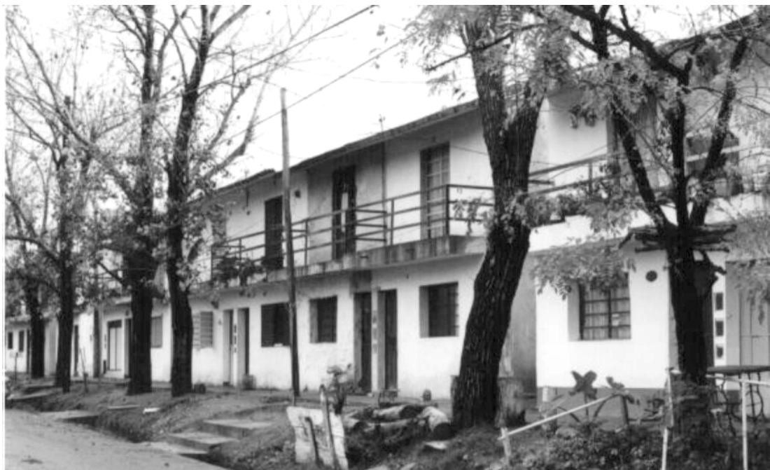
Foto 12. Saladillo Sur, conjunto de viviendas.
