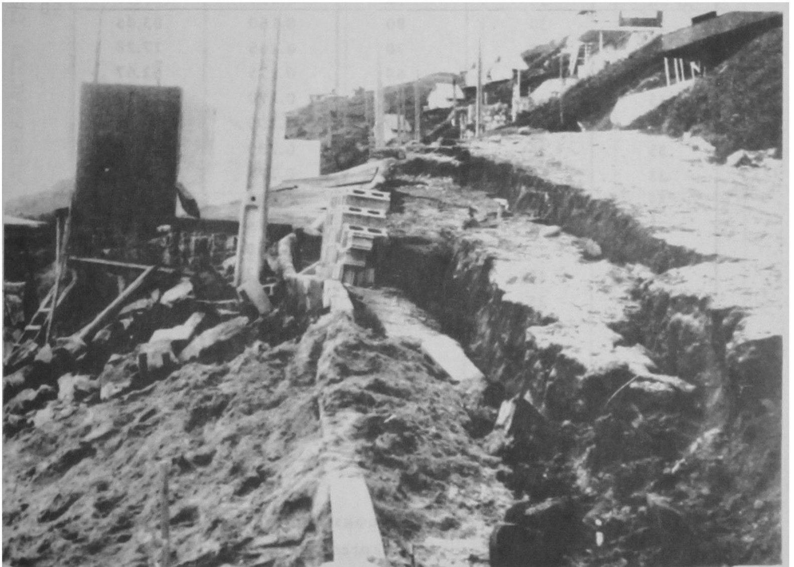
Fig. 4. Corrimiento de taludes de dunas en Reñaca, sismo de Julio de 1971.
