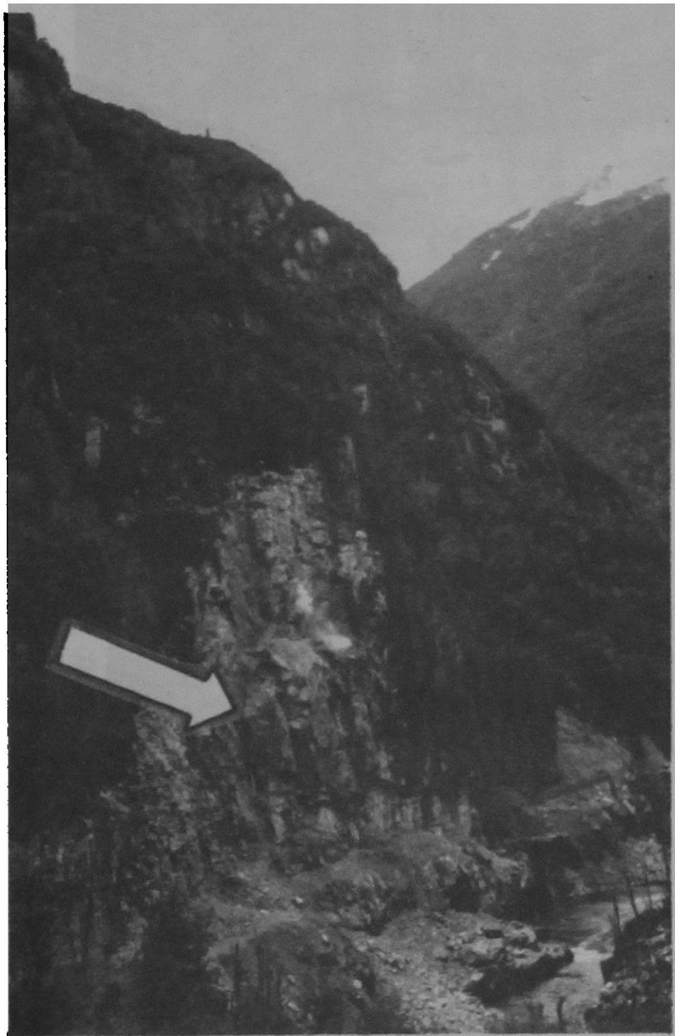
Fig. 7. Bloque potencialmente inestable cuyo análisis de estabilidad requiere determinar los parámetros de resistencia al corte mediante ensayos in situ 8 .
